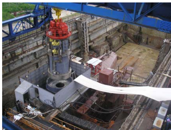
FIG. 6. La descarga del combustible de un submarino nuclear dañado supuso la retirada del núcleo del reactor con refrigeración por metal líquido.
