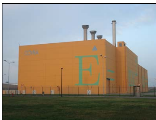
FIG. 1. Edificio para el almacenamiento provisional de desechos radiactivos de actividad alta y combustible gastado en el emplazamiento de la Organización Central para los Desechos Radiactivos, en los Países Bajos, diseñado para ofrecer almacenamiento seguro durante al menos 100 años.
