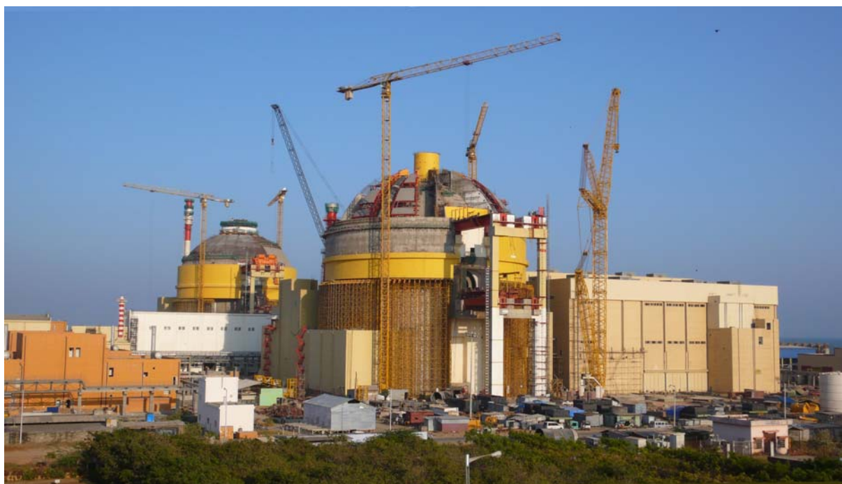
FIG. 1. Construcción de reactores refrigerados por agua ( 2 \times 917 \text{ MW(e)} ) en Kundankulam (India).
