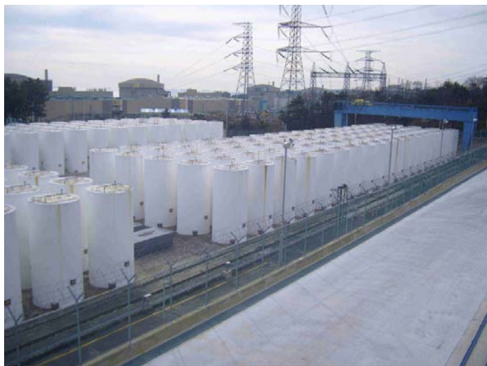
FIG. 2. Cofres de almacenamiento en seco en el emplazamiento de la central nuclear de Wolsong (República de Corea).
