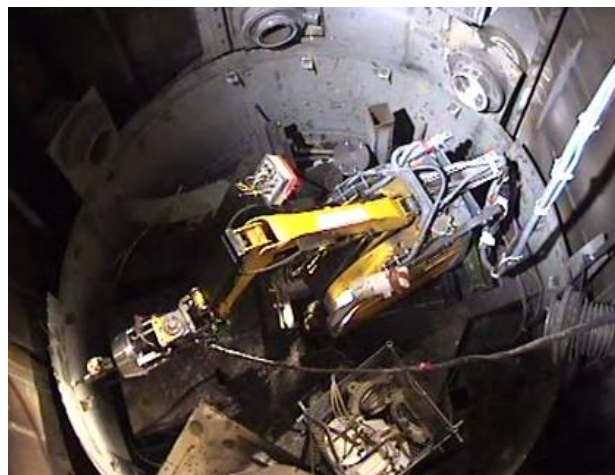
FIG. 3. Remoción teledirigida de revestimiento estanco en el reactor de investigación SILOE, en Grenoble (Francia).
