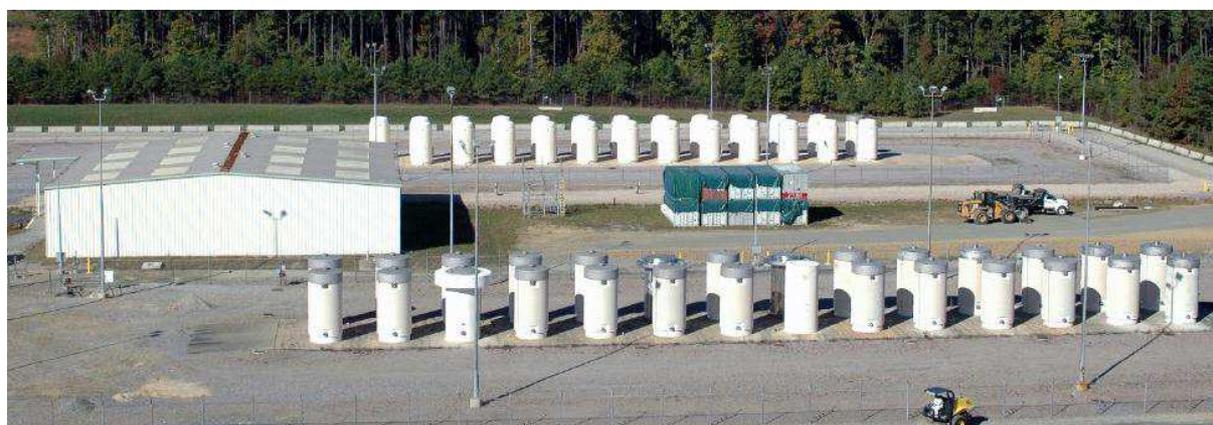
*РИС. 4. Независимое хранилище отработавшего топлива на АЭС «Сарри», Вирджиния, США, - расположенная рядом с реактором установка для сухого контейнерного хранения.*
