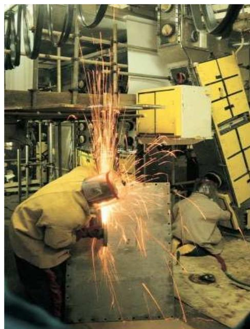
*Fig. 1. Desmantelamiento de una caja de guantes en una instalación de fabricación de combustible.*
