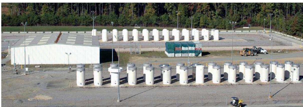
*Fig. 4. Instalación independiente de almacenamiento de combustible gastado en la central nuclear de Surry en Virginia (EE.UU.), una instalación de almacenamiento en cofres secos en el reactor.*
