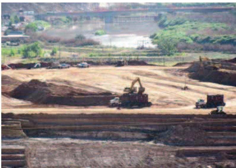
FIG. 1. Remédiation d'un ancien site de préparation de minerai d'uranium dans l'Utah (États-Unis d'Amérique).
