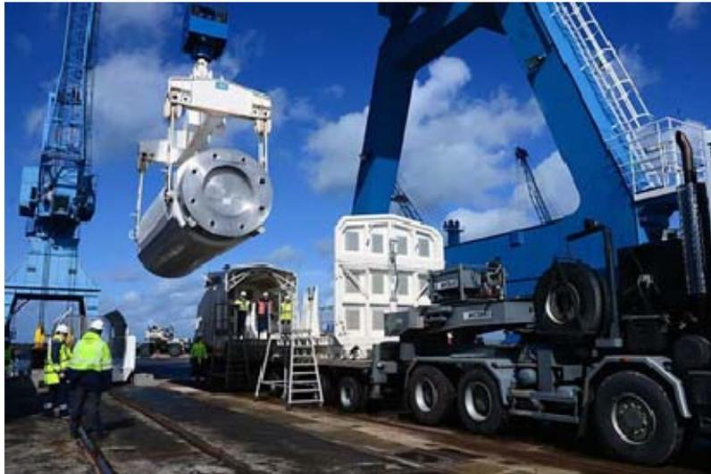
*Fig. 3. Carga de un cofre de transporte que contiene material radiactivo, para su transporte.*
