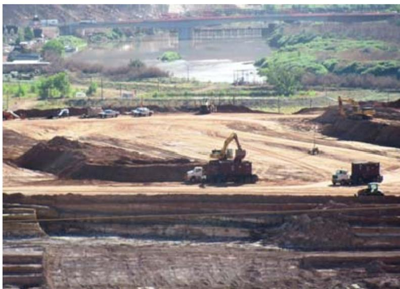
Fig. 1. Restauración de una antigua instalación de tratamiento de uranio en Utah (EE.UU.).
