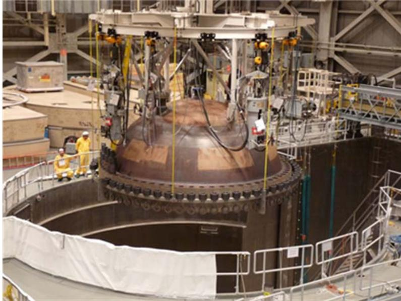
*Fig. 4. Alzamiento de la tapa de la vasija de un reactor en la central nuclear de Laguna Verde (México).
