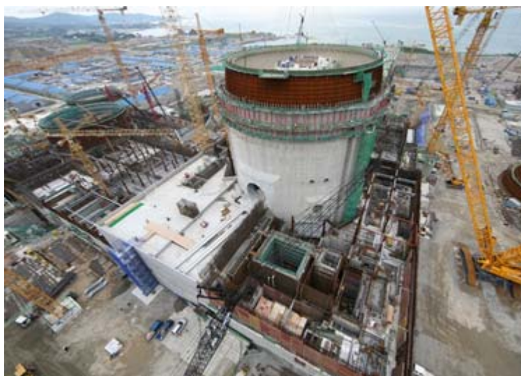
图 A-2. 大韩民国的新古里 3 号反应堆正在建设。
