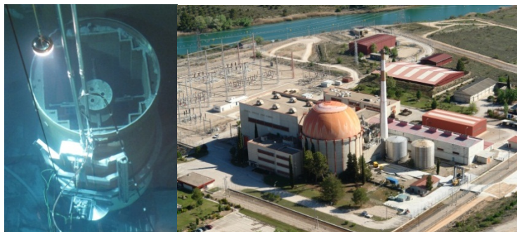
图 A-17. 何塞·卡夫雷拉核电厂（右）核反应堆内部构件（左）正在拆除（照片来源：西班牙国家放射性废物管理公司）。
