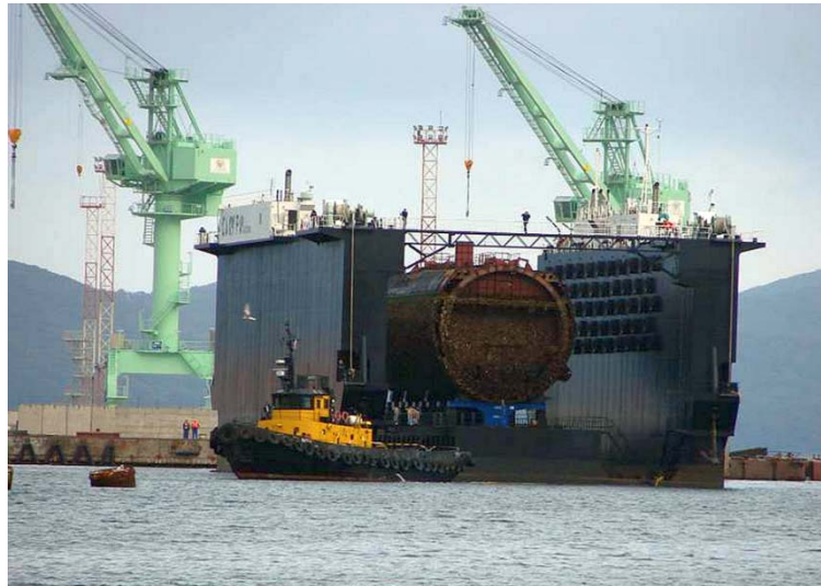
图 A-14. 正在拆除一艘核潜艇。
