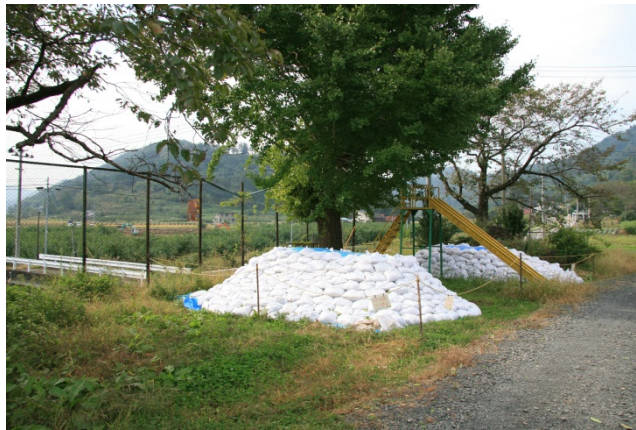
图 A-16. 2011 年 10 月伊达市富成小学校示范治理项目去除土壤的临时贮存。
