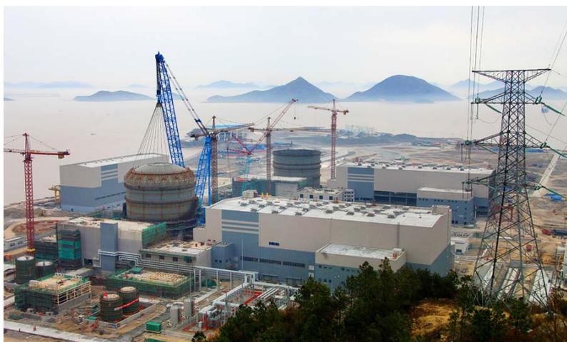
*РИС. 3. Установка купола защитной оболочки на энергоблоке атомной электростанции "Саньмэнь" – одной из многочисленных АЭС, строящихся в Китае в рамках расширения ядерно-энергетической программы страны. (фотография предоставлена Национальной ядерной корпорацией Китая.)*
