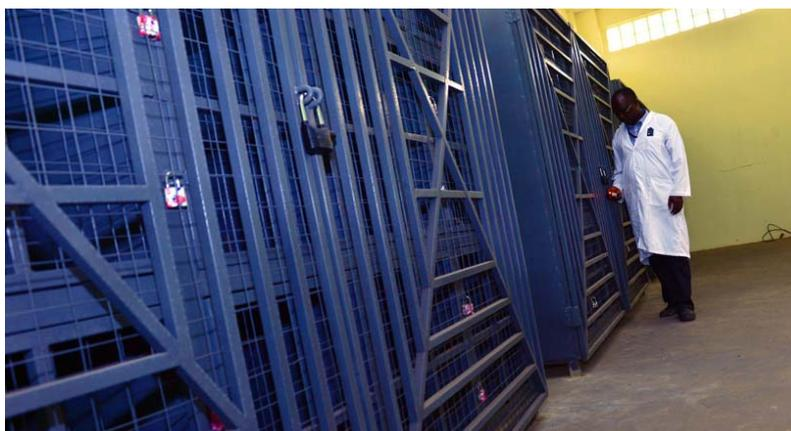
*РИС. 2. Охраняемое хранилище на установке в Гане, оснащенное различными видами физических барьеров в целях предотвращения хищения радиоактивного материала или несанкционированного доступа к нему.*
