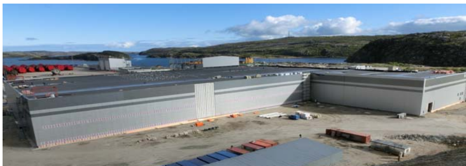
РИС. А-14. Строительство регионального центра кондиционирования и долгосрочного хранения радиоактивных отходов в северо-западном регионе России (фото: Energiewerke Nord GmbH).
