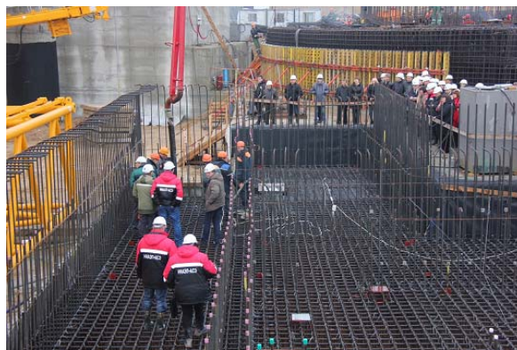
РИС. А-4. Начало строительства первой белорусской АЭС на площадке Островец 6 ноября 2013 года (фото: Дирекция строительства атомной электростанции, Беларусь).
