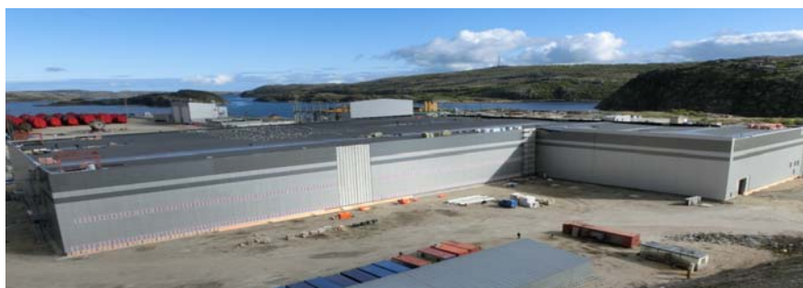
Fig. A-14. Construcción del Centro regional de acondicionamiento de desechos radiactivos y almacenamiento a largo plazo en el noroeste de Rusia. (Fotografía: Energiewerke Nord GmbH).
