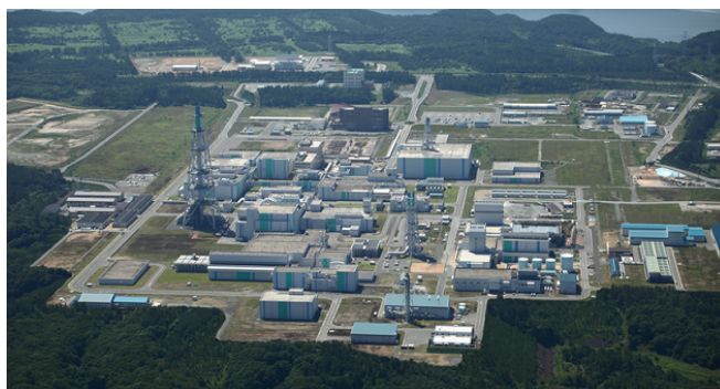
Fig. A-13. Planta de reprocesamiento de Rokkasho (Japón). (Fotografía: JNFL).
