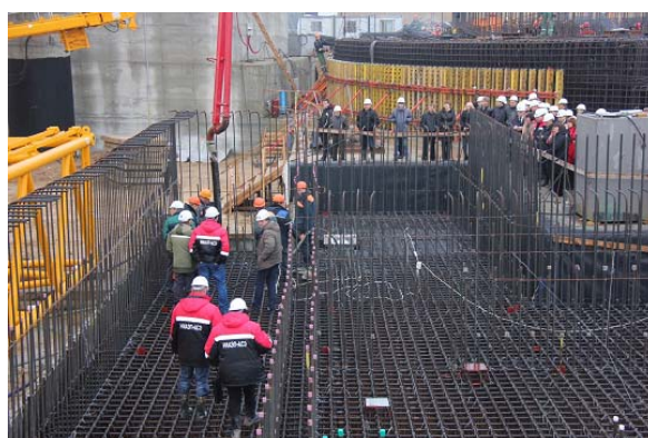
Fig. A-4. La construcción de la primera central nuclear de Belarús comenzó el 6 de noviembre de 2013 en el emplazamiento de Ostrovets. (Fotografía: Dirección de Construcción de Centrales Nucleares de Belarús).
