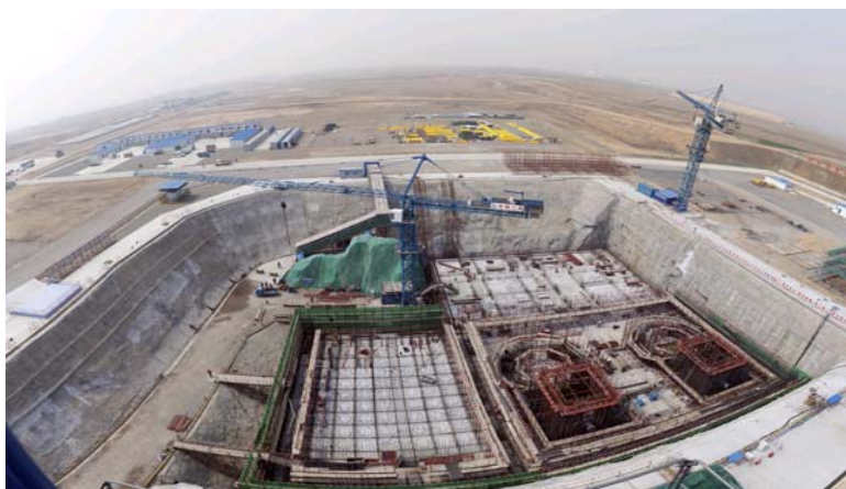
Fig. B-2. Lugar donde se construye el HTR-PM en la bahía de Shidao, ciudad de Weihai (China). (Fotografía: Instituto de Tecnología de la Energía Nuclear y de las Nuevas Energías).
