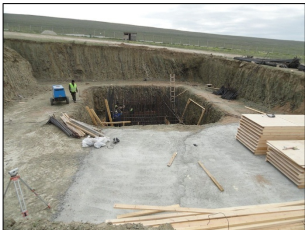
AZB/8/002. Начальные этапы строительства здания установки по радиационной обработке в Азербайджане.
