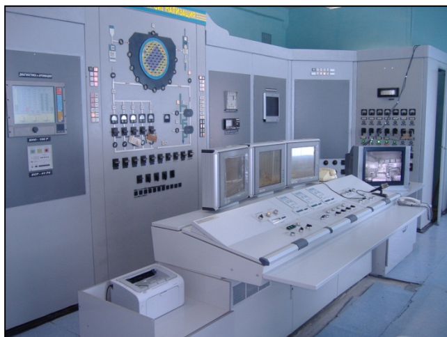
UZB/9/005: Nueva consola digital de IyC del reactor de investigación WWR-SM de Uzbekistán.
