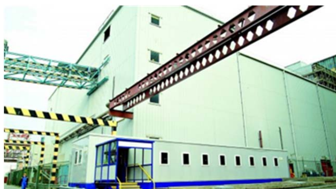
图 A-8. 塞拉菲尔德镁诺克斯后处理厂完成运行 50 年。(照片由塞拉菲尔德有限公司提供)
