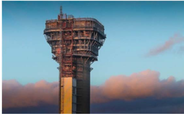
图 A-10. 温斯克尔 1 号堆烟囱中的过滤器通道退役。（照片由塞拉菲尔德有限公司提供）
