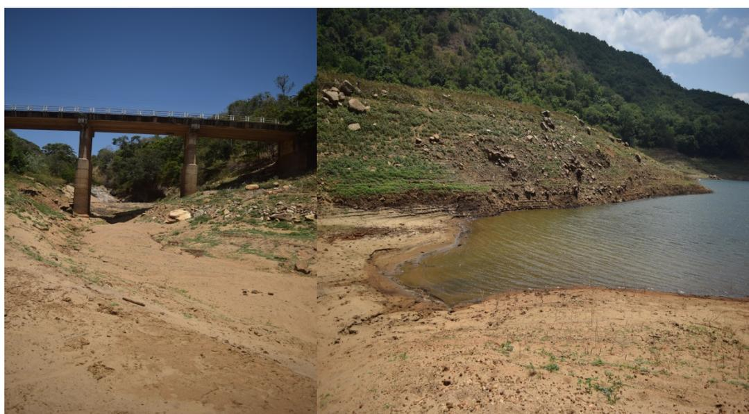
*РИС. G-2. Вызванный эрозией перенос отложений из водосборного бассейна к водонепроницаемой перемычке в Шри-Ланке (Фото: МАГАТЭ)*
