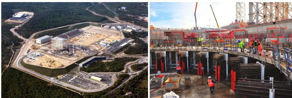
РИС. В-6. Вид сверху на строительную площадку ИТЭР в августе 2015 года (слева). По состоянию на 21 октября 2015 года (справа) было построено 200° сегмента биологической защиты ИТЭР, представляющего собой окружающую установку "кольцо" толщиной 3,2 метра (Фото: ИТЭР)
