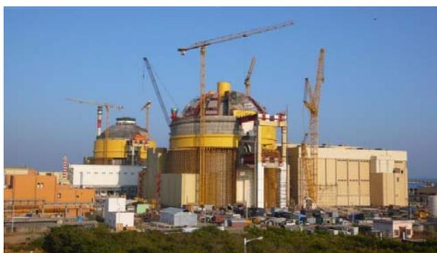
*Fig. B-1. Central nuclear WWER-1000 en construcción en el emplazamiento nuclear de Kudankulam. (Fotografía: OIEA)*
