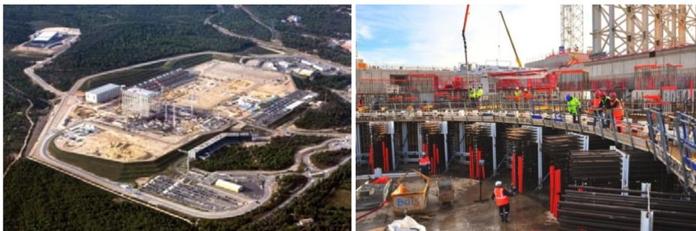
*Fig. B-6. Vista aérea del lugar de construcción del ITER en agosto de 2015 (izquierda). Al 21 de octubre de 2015 (derecha), se había construido el segmento de 200° del blindaje ecológico del ITER, el “anillo” de 3,2 m de grosor que rodeará la máquina. (Fotografías: ITER)*
