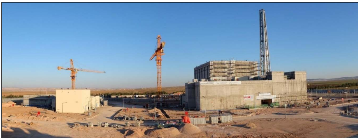
Строительство на площадке атомной электростанции в Иордании.
