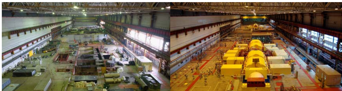
РИС. А-7. Работы по демонтажу в турбинных залах энергоблоков 1 (слева) и 2 (справа) Игналинской АЭС в Литве (Фото: Игналинская АЭС).
