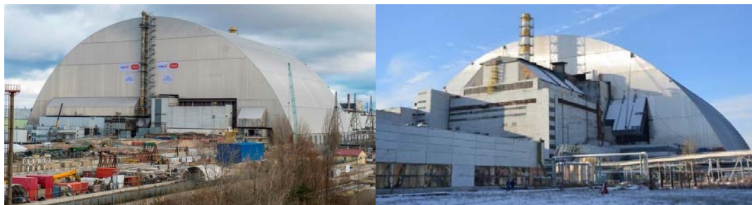
РИС. А-6. Новый безопасный конфайнмент над 4-м энергоблоком Чернобыльской АЭС (слева, вид со строительной площадки, справа, вид со стороны 3-го энергоблока). Высота сооружения – 108 метров, длина – 162 метра, ширина – 257 метров, вес – примерно 36 000 тонн. (Фото: Чернобыльская АЭС).
