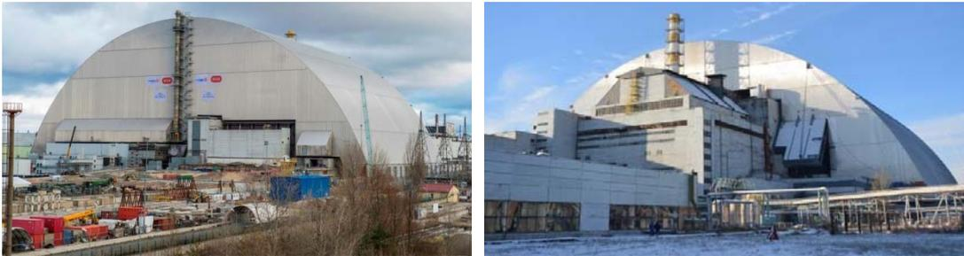
*Fig. A-6. Nuevo confinamiento seguro en torno a la unidad 4 de la central nuclear de Chernóbil (izquierda, vista desde el sitio de construcción; derecha, vista desde la unidad 3). La estructura mide 108 metros de altura, 162 metros de longitud y 257 metros de anchura, y pesa alrededor de 36 000 toneladas (Fotografías: central nuclear de Chernóbil).*
