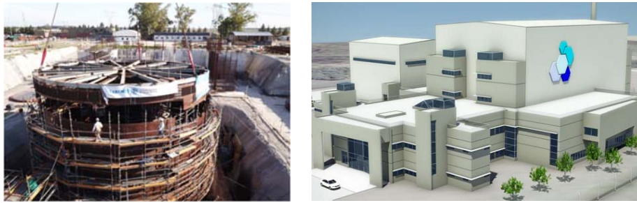
图 B-3. 正在建造的 CAREM-25（左），最终电厂总体布置（右）。（照片来源：阿根廷国家原子能委员会）
