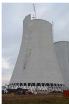
图 A-6. 2017 年 10 月，拆除斯洛伐克 V1 博胡尼斯核电厂冷却塔。（照片来源：核和退役公司）。
