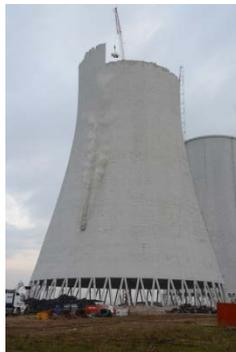
*FIG. A-6. Démolition des tours de refroidissement de la centrale nucléaire de Bohunice VI, en Slovaquie, en octobre 2017 (Photo : JAVYS).*
