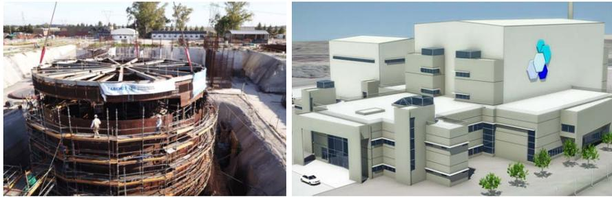
FIG. B-3. Modèle CAREM-25 en construction (à gauche) ;
