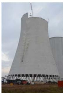
*Fig. A-6. Demolición de las torres de refrigeración de la central nuclear de Bohunice V1, Eslovaquia, octubre de 2017. (Fotografía: JAVYS)*
