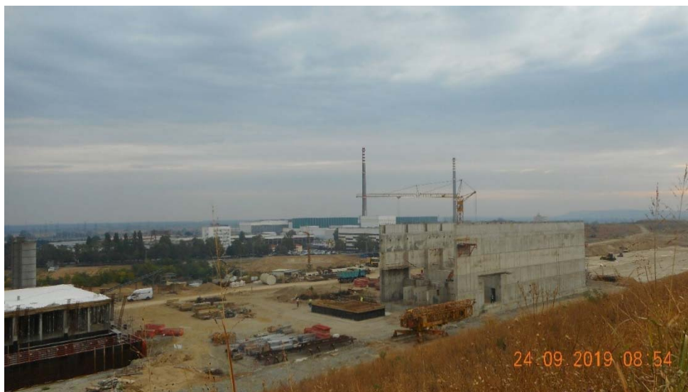
图 A-17. 科兹洛杜伊核电厂附近雷蒂安娜场址的国家处置设施的建设，显示了行政综合大楼的一部分（左）、废物接收和缓冲贮存大楼（右）和 1 号处置平台的黄土水泥地基（最右）。
