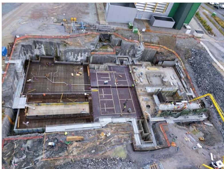
图 A-16. 芬兰核废物管理专家组织的乏核燃料封装厂的建设。 (照片：芬兰核废物管理专家组)
