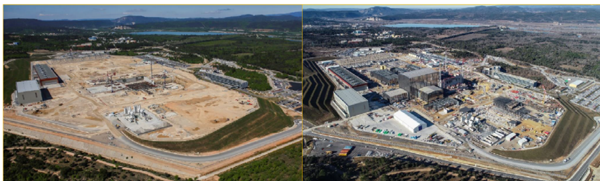
图 B-7. 2014 年 4 月（左）和 2019 年 10 月（右）的国际热核实验堆施工现场照片。 （照片：国际热核实验堆）
