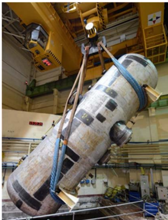
图 A-12. 从斯洛伐克退役的博胡尼斯 V-1 核电厂拆除 12 台重 145 吨的蒸汽发生器中的最后一台。(照片：核和退役公司 JAVYS)
