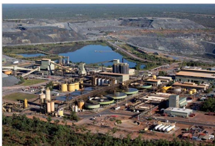
图 A-14. 兰杰铀矿场址。(照片：澳大利亚能源资源公司)
