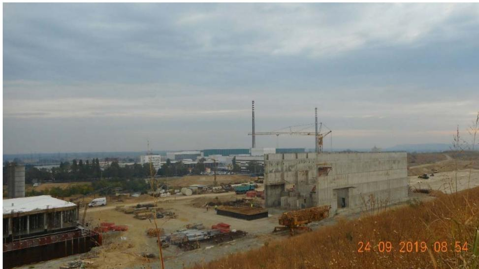
*FIG. A-17. Chantier de l'installation de stockage nationale sur le site de Radiana, près de la centrale nucléaire de Kozloduy. On peut voir le bâtiment administratif (à gauche), le bâtiment de réception et d'entreposage tampon des déchets (à droite) ainsi que la fondation en loess-ciment de la plateforme de stockage n° 1 (tout à droite).*
