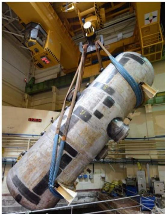
*FIG. A-12. Enlèvement du dernier des 12 générateurs de vapeur de 145 tonnes de la centrale nucléaire de Bohunice V-1 déclassée, en Slovaquie. (Photo : Société de l'énergie nucléaire et du déclasserment JAVYS)*
