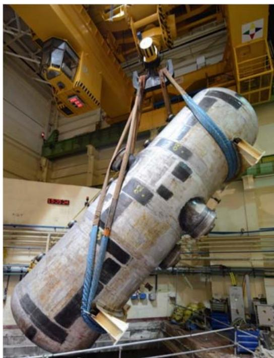
*РИС. А-12. Удаление последнего из 12 парогенераторов весом 145 тонн на выведенной из эксплуатации АЭС «Богунце V-1» в Словакии. (Фото: «Ядро́ва а вираде́вация сполчностъ»)*
