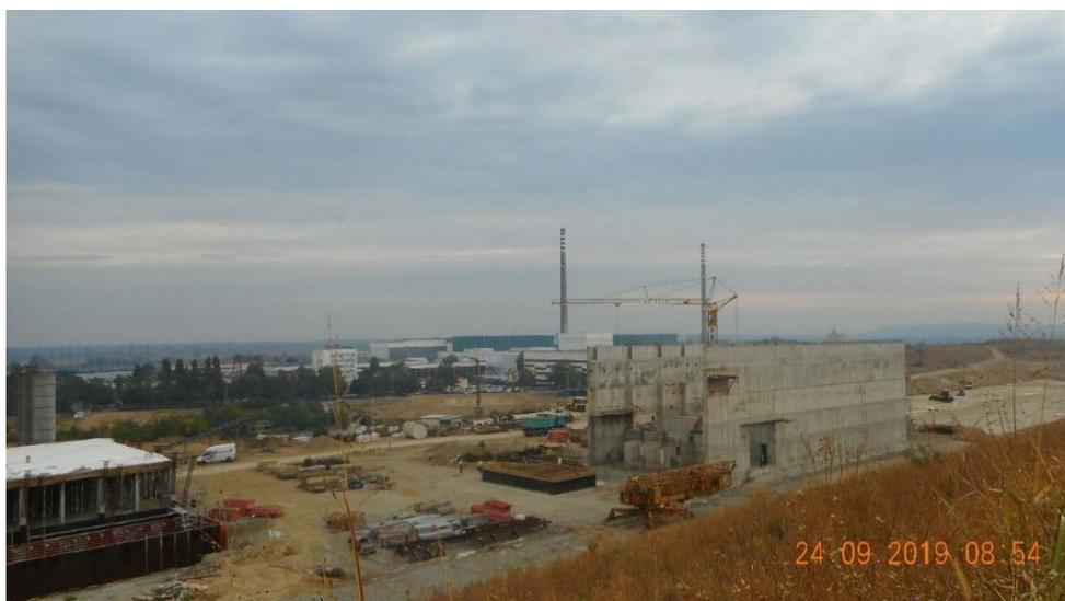
*Рис. А-17. Строительство НПЗ на площадке «Радiana» поблизости от АЭС «Козлодуй»; на фотографии представлена часть административного комплекса (слева), здание приема и буферного хранения отходов (справа), и цементно-грунтовое основание платформы захоронения № 1 (справа вдали).*
