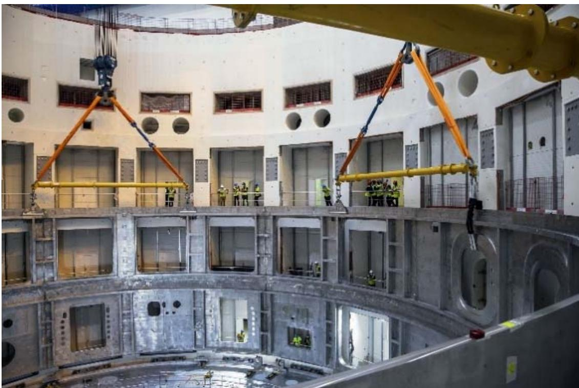
*FIG. A-6. Une fois la base du cryostat installée, le cylindre inférieur du cryostat de 375 tonnes a été descendu dans le puits et soudé à la base. (Photo : Organisation ITER)*
