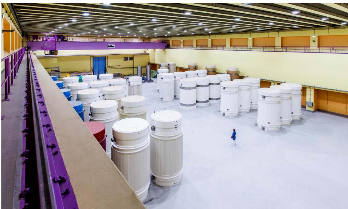
*FIG. C-5. La salle d'entreposage des châteaux au ZWILAG (Suisse) qui accueille les déchets de haute activité vitrifiés des usines de retraitement, ainsi que des éléments combustibles usés provenant des centrales nucléaires suisses. (Photo : ZWILAG)*
