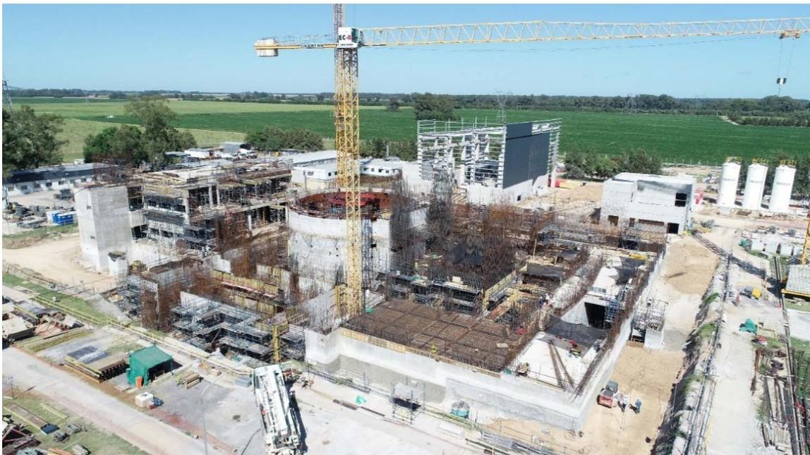
*FIG. A-2. Le réacteur CAREM, à un stade de construction avancé sur un site adjacent à la centrale nucléaire Atucha II/Néstor Carlos Kirchner (Argentine) devrait être mis en service d'ici à 2024 et produire 30 MWe à des fins expérimentales. (Photo : CNEA)*
