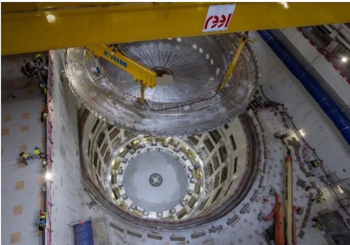
*FIG. A-5. La base du cryostat de 1 250 tonnes, premier grand composant à avoir été installé au fond du puits d'assemblage du tokamak de 30 mètres de haut. (Photo : Organisation ITER)*
