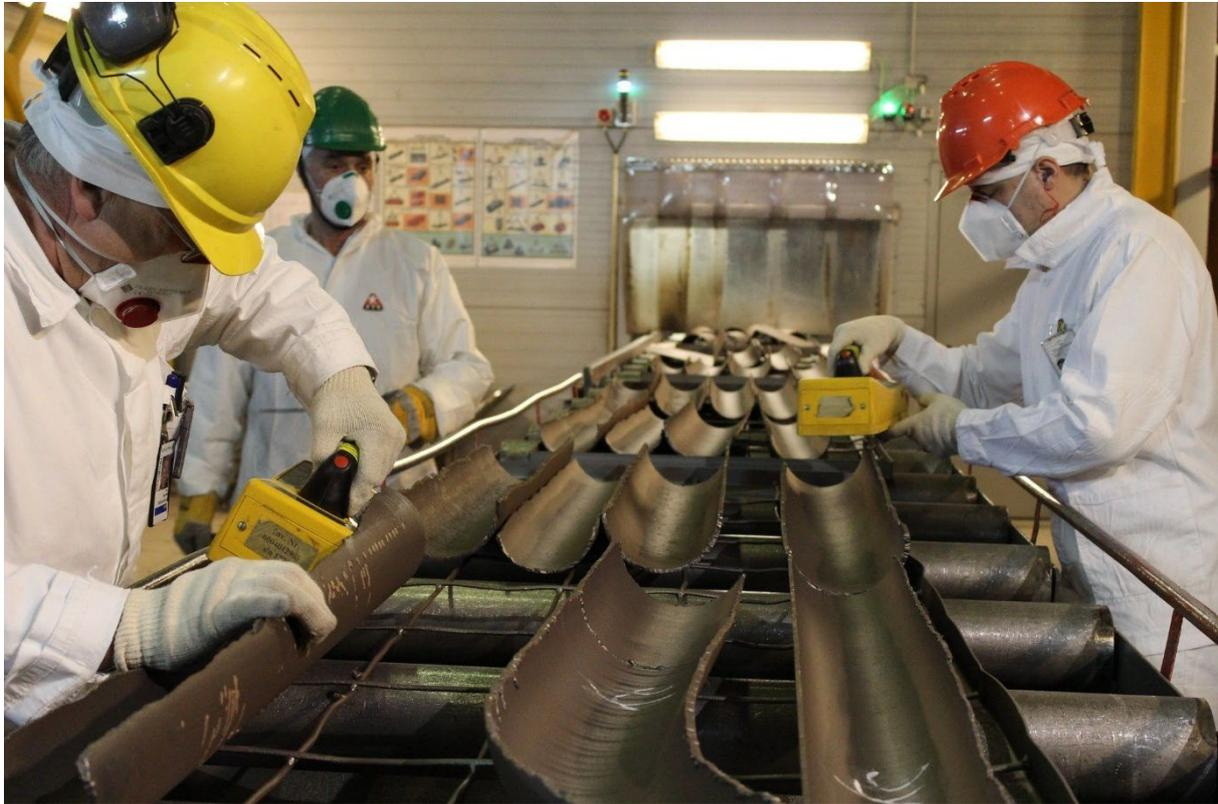
*Des travailleurs qui démantèlent la salle des turbines de la centrale nucléaire d'Ignalina mesurent la ferraille pour déceler des traces de rayonnement (photo : J. Donovan/AIEA)*
