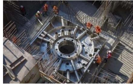
*РИС. D-1 с. Монтаж плиты перекрытия в основании шахты реактора МБИР в государственном научном центре «Научно-исследовательский институт атомных реакторов», Димитровград, Российская Федерация. (Фото: Росатом)*
