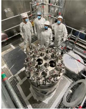
*РИС. D-1 б. Установка крышки корпуса реактора «Жюль Горовиц» в Кадараше, Франция. (Фото: КАЭ)*
