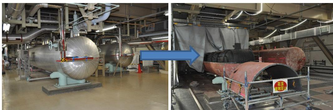
*FIG. C.2. Démantèlement d'un réchauffeur d'eau d'alimentation à haute pression
