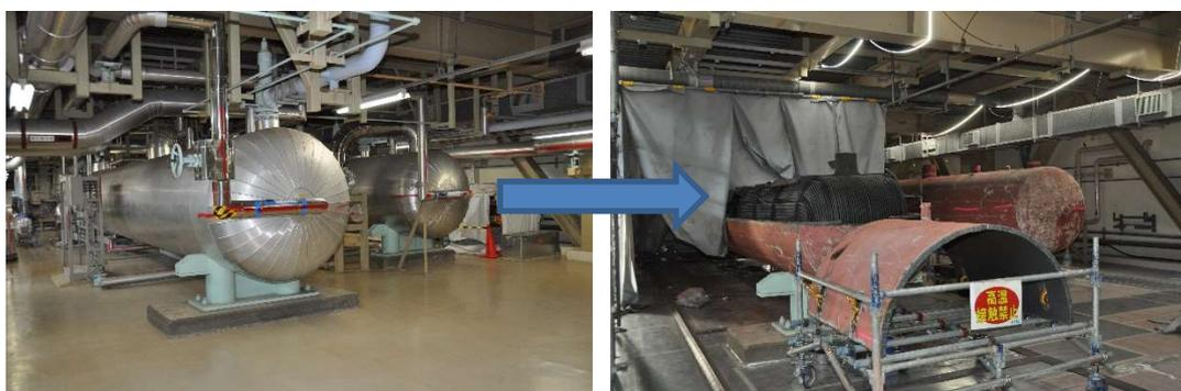
*Fig. C.2. Desmantelamiento de un calefactor de agua de alimentación de alta presión como parte de la clausura del reactor Monju. (Fuente: JAEA)*
