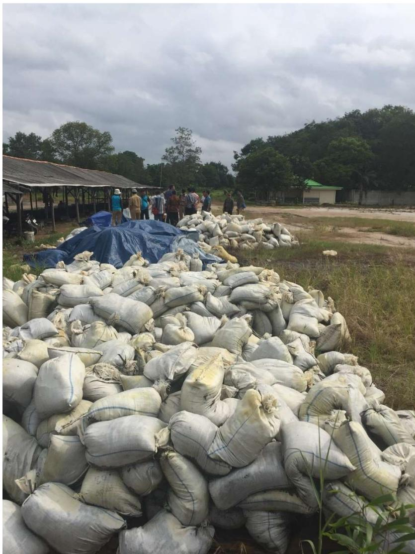
*Fig. C.3. Almacenamiento provisional de residuos NORM. (Fuente: OIEA)*
