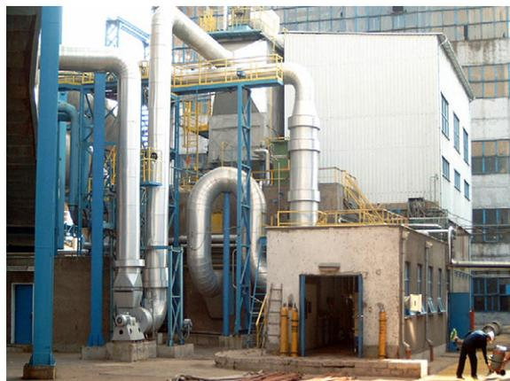
*Fig. 1. Installation pilote pour le traitement des gaz de fumée par faisceaux d'électrons à la centrale thermique Maritsa Est 2 (Bulgarie).*
