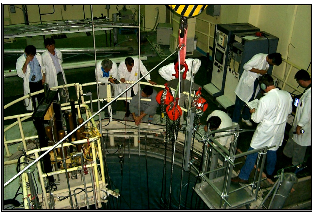
En enero de 2005, se cargó combustible de UPE sin irradiar en el reactor de investigación Pitesti (en Rumania), tras retirar el combustible de UME del núcleo del reactor y preparar ese combustible para su repatriación.
