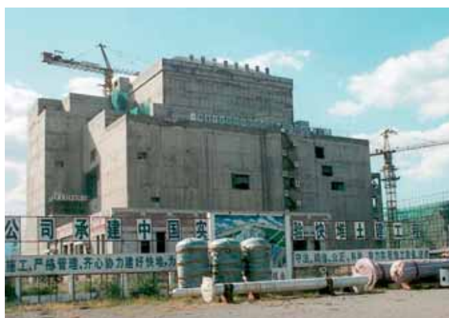
FIG. 2. El reactor rápido experimental chino en construcción.
