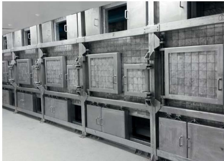
**6** Чтобы обеспечить безопасность и защиту “горячей зоны” установки, т.е. помещения, в котором находятся радиоактивные материалы, были установлены свинцовые стены и двери. “Горячей зоной” называют также участок, куда доставляют радиоактивные материалы и откуда поступает готовая продукция (радиофармпрепараты) после обработки в горячих камерах.
