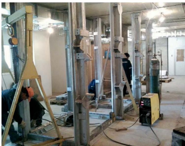
**3** Потребовалось частично разрушить здание, чтобы возвести новые стены и усиленные перекрытия, способные выдержать вес новых горячих камер. Для сооружения бетонных опор был заключен договор подряда со специализированной компанией. Данный этап строительства включал также работы по сборке несущей конструкции для свинцовых блоков.
