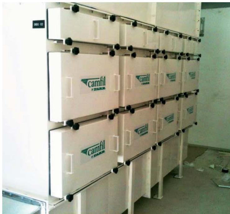
**8** Для повышения уровня безопасности новые горячие камеры были оснащены сложной вентиляционной системой двукратной фильтрации с фильтрами предварительной очистки, воздушными фильтрами тонкой очистки (HEPA-фильтрами) и активными угольными фильтрами.
