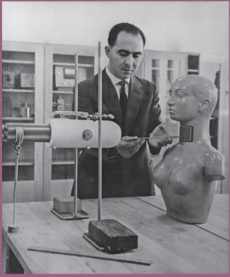
Бюстовый манекен, сконструированный в МАГАТЭ в 1961 году для демонстрации точных измерений поглощения радиоактивного иода щитовидной железой, которая регулирует обмен веществ в организме.
